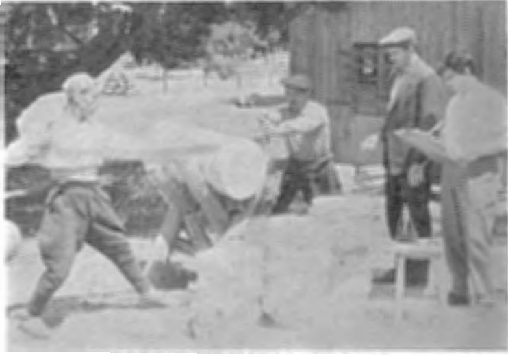
Şekil 11. Çeşitli kesim aletlerinin iş verimlerini tayin denemesi
