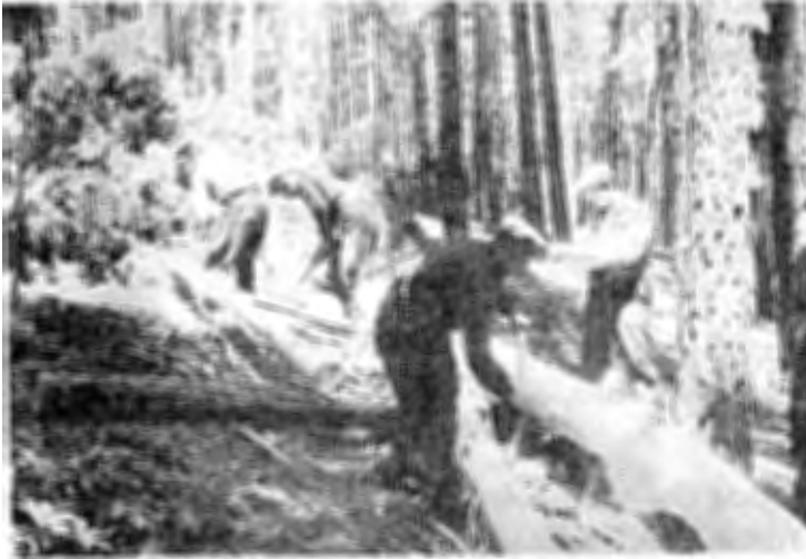
Şekil 12. İstihsalde iş ve fiyat analizleri denemesinin arazi çalışmalarından bazı safhalar.
